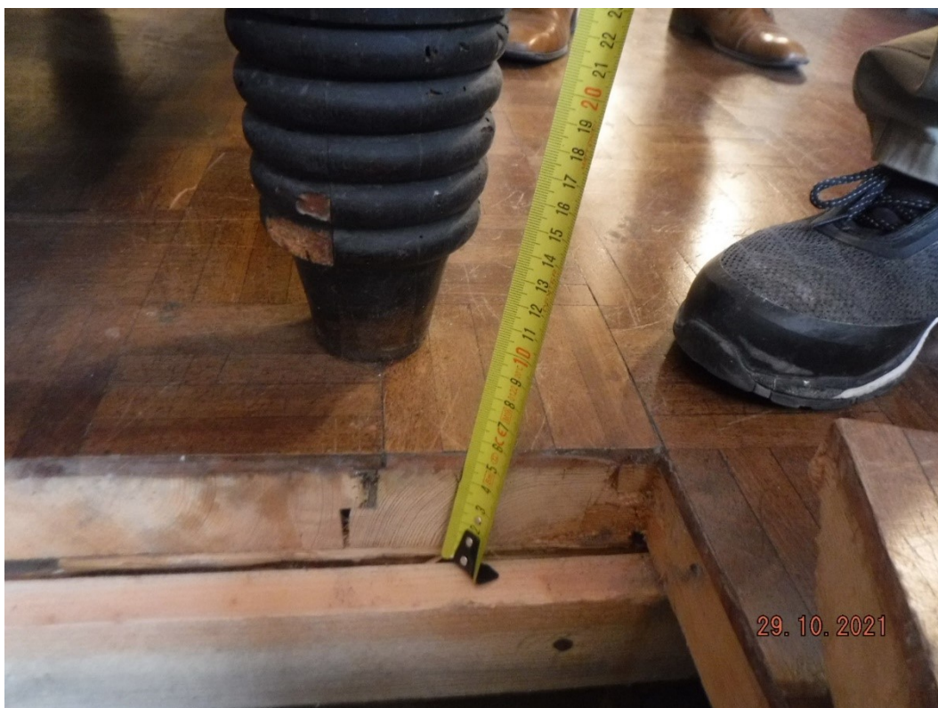
F4 – Tabuado com espessura da ordem de 4 cm com colagem de outro tipo de pavimento na sua superfície superior.
