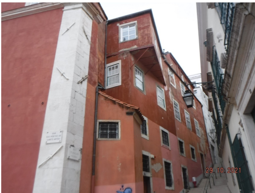
F12 – Estrutura metálica de suporte parcial do pavimento da cozinha.
