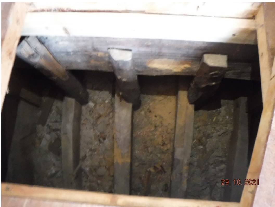
F2 – Interior da abertura de inspeção 1– Barrotamento do pavimento com orientação perpendicular às costelas da abóboda.
