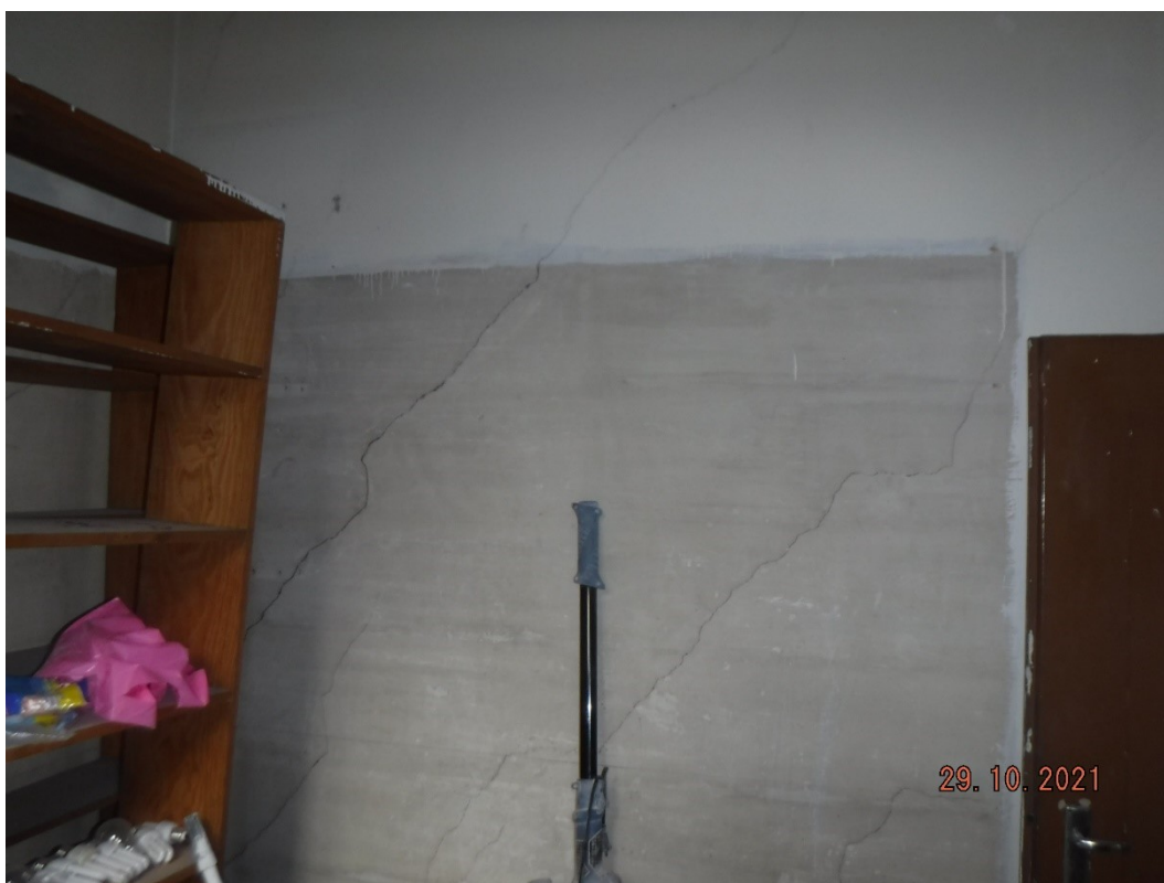
F8 – Fissuras na parede decorrentes da deformação do pavimento.
