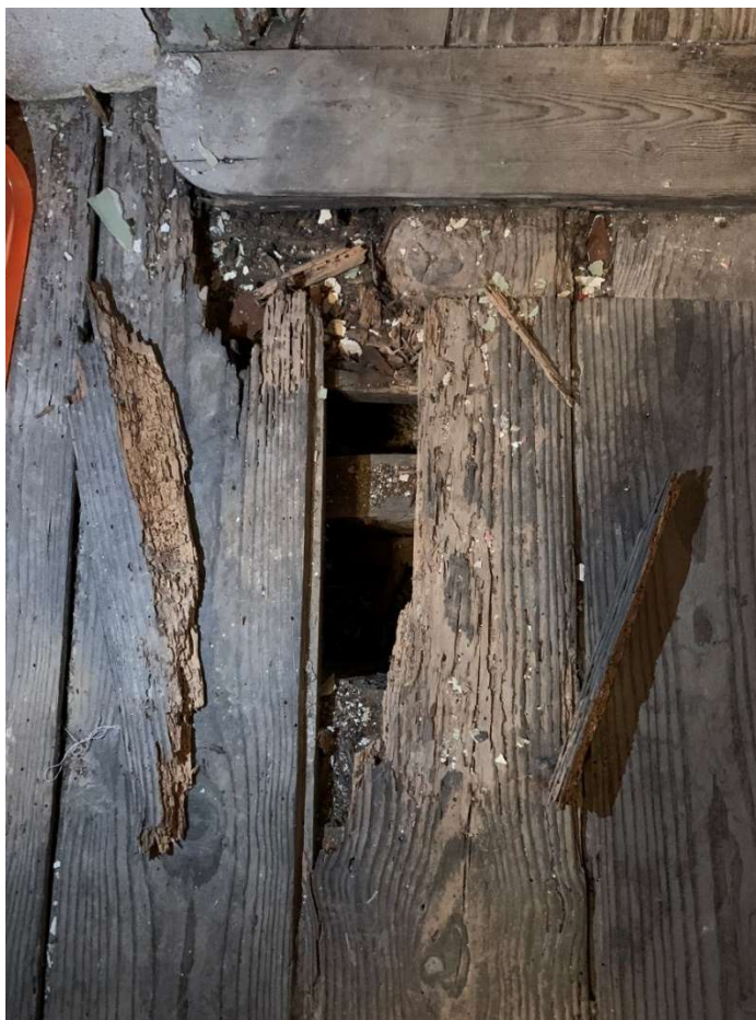
Figura 6 – Apodrecimento de parte de uma prancha de madeira em pavimento do piso 2 devido a infiltrações provenientes da casa de banho do piso 3
