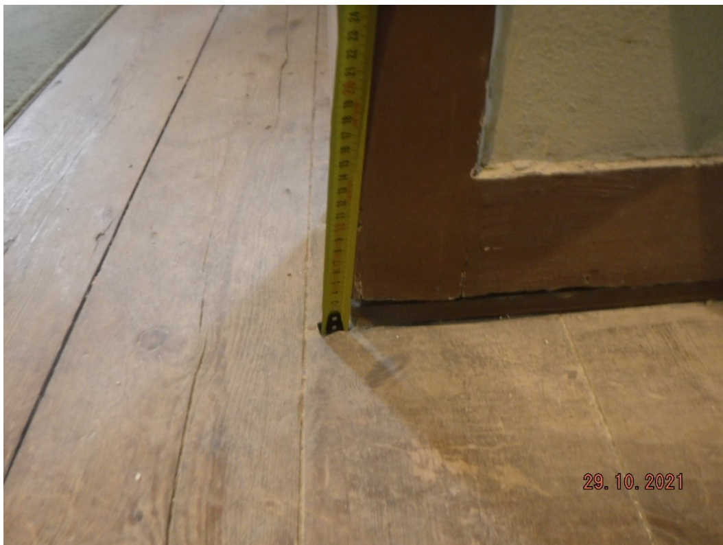
F7 – Deformação do pavimento do sótão, com uma flecha da ordem de 4 cm.
