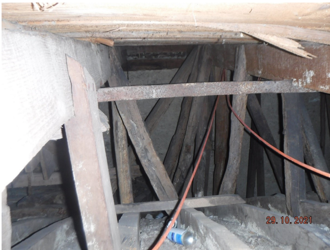
F9 – Interior da abertura de inspeção 4 – Barrotamento do pavimento com orientação paralela às costelas da abóboda.
