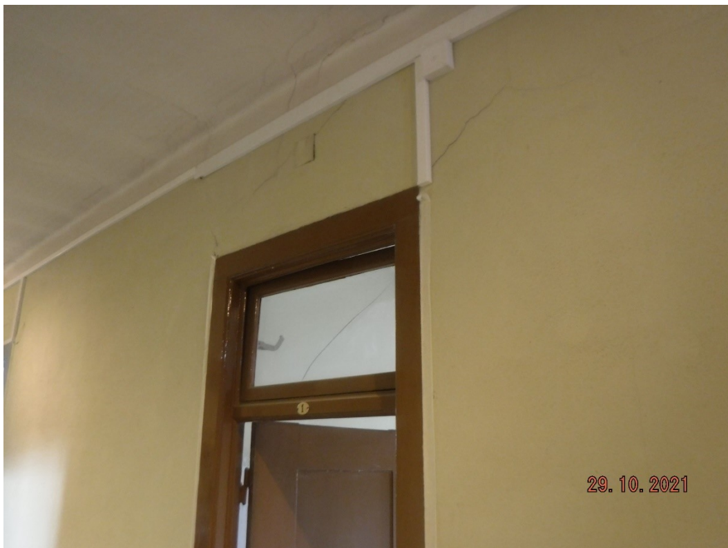
F5 – Bandeira do vão de porta com o vidro partido, zona sob a qual se observa a deformação do barrotamento.
