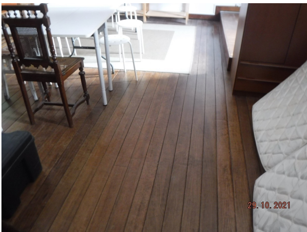
F12 – Pavimento de madeira novo aplicado sobre o soalho existente.
