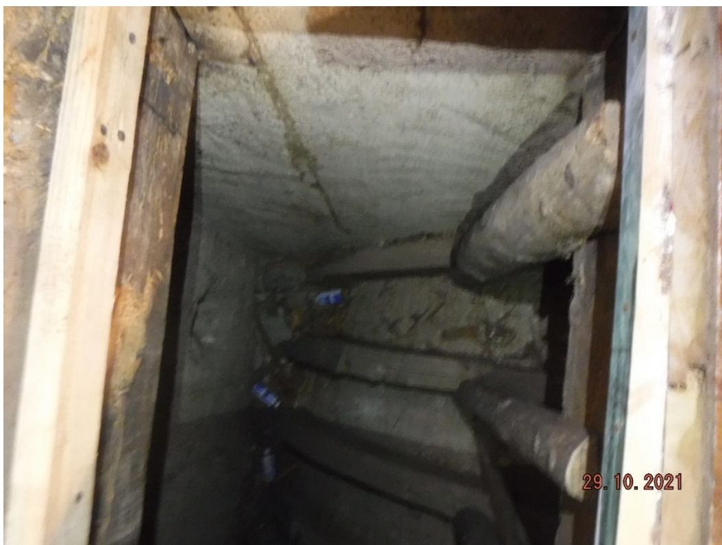
F6 – Interior da abertura de inspeção 2 – Barrotamento do pavimento com orientação perpendicular às costelas da abóboda.
