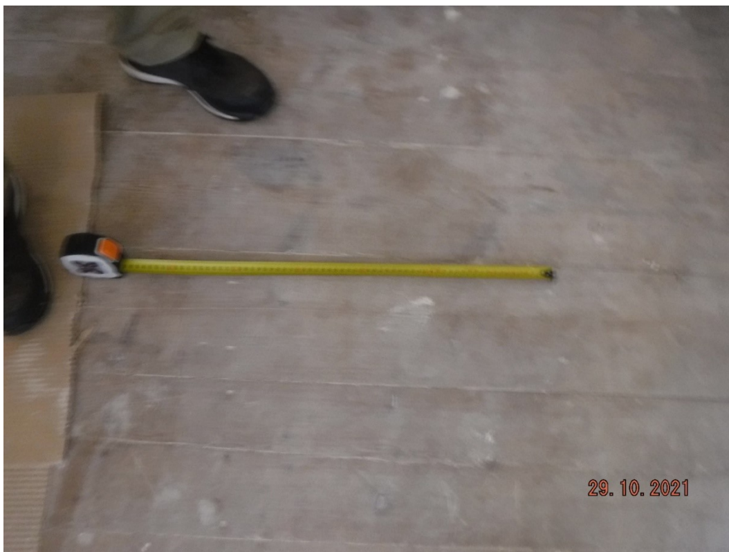
F1 – Cerca de 0.40m de distância entre pregagens do soalho, evidência do afastamento entre barrotes
