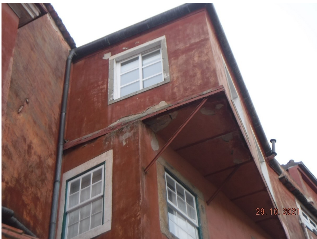
F13 – Idem, em fotografia mais aproximada. Toda a estrutura metálica deve ser tratada contra a corrosão. As escoras, como medida cautelar, devem ser reforçadas com perfis de seção idêntica.
