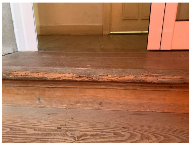
Figura 5 – Fragilização do bordo do degrau em madeira na parte correspondente ao borne por ataque de carunchos
